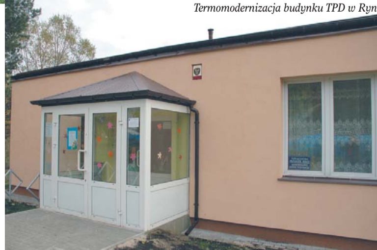
Termomodernizacja budynku TPD w Ryńcu
